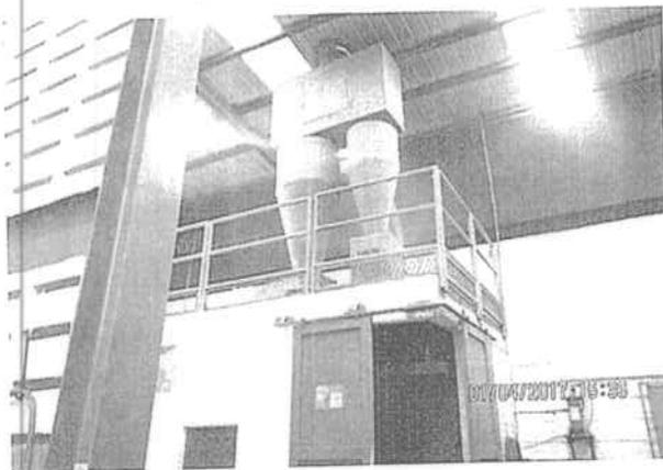
**Foto 4.** Cabina del Sandblasting con sistema de succión y retención de finos.
